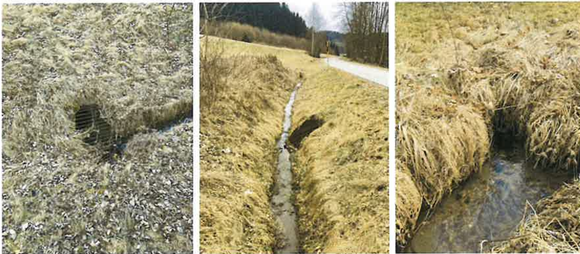
Abbildung 5: Einläufe &amp; Auslauf Verrohrung (links: Einlauf Nord, Mitte: Einlauf Süd, rechts: Auslauf) [2]
