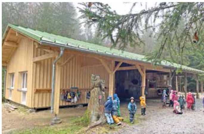
Die neue Waldhütte im Waldkindergarten beherbergt jetzt eine weitere Kindergartengruppe.
