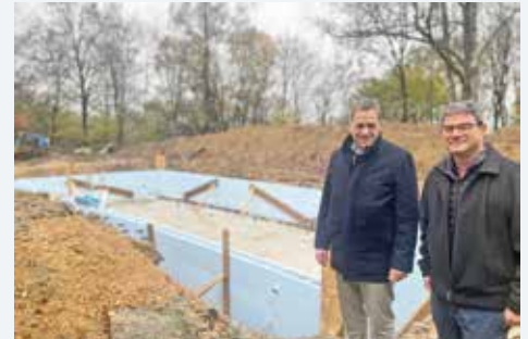
Baustelle Außenpool am Michel-Hotel
