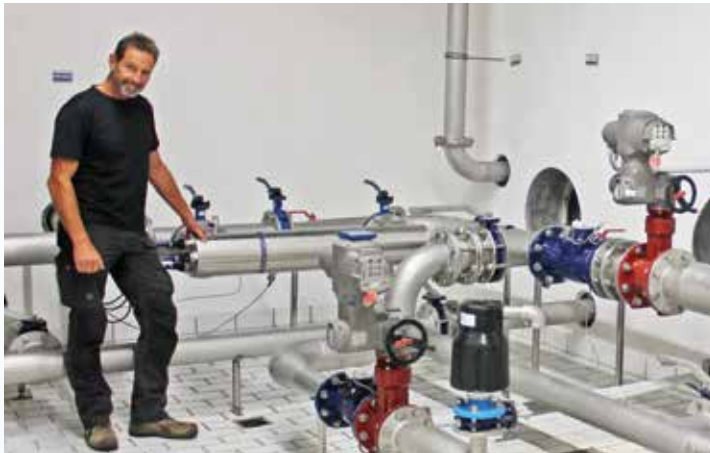
Roman Böhm an der UV-Desinfektionsanlage des Hochbehälters Elmberg
