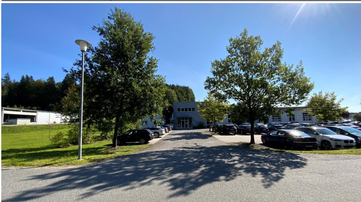
Abbildung 11: Fotoaufnahme zum bestehenden Verwaltungsgebäude nach Osten, aufgenommen von der Josef-Buchinger-Straße aus (Quelle: Brunner Architekten, September 2021)
