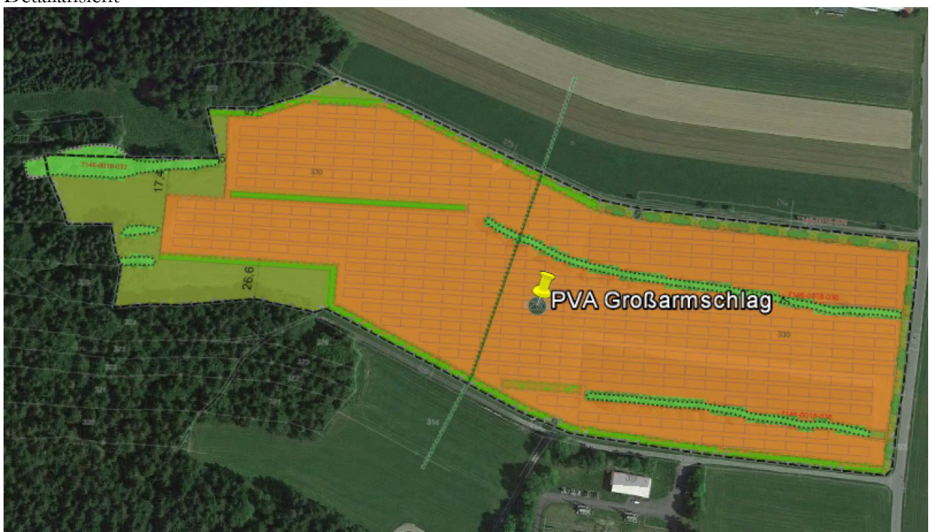
Bild 2.1.3: Luftbild der PV-Anlage (Quelle: Google Earth / SolPEG)
