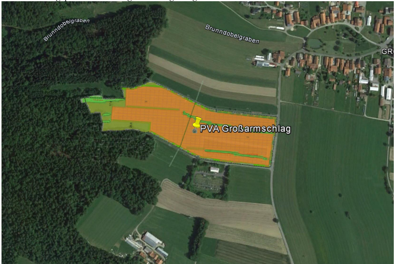
Bild 2.1.2: Luftbild der PV-Anlage (Quelle: Google Earth / SolPEG)
