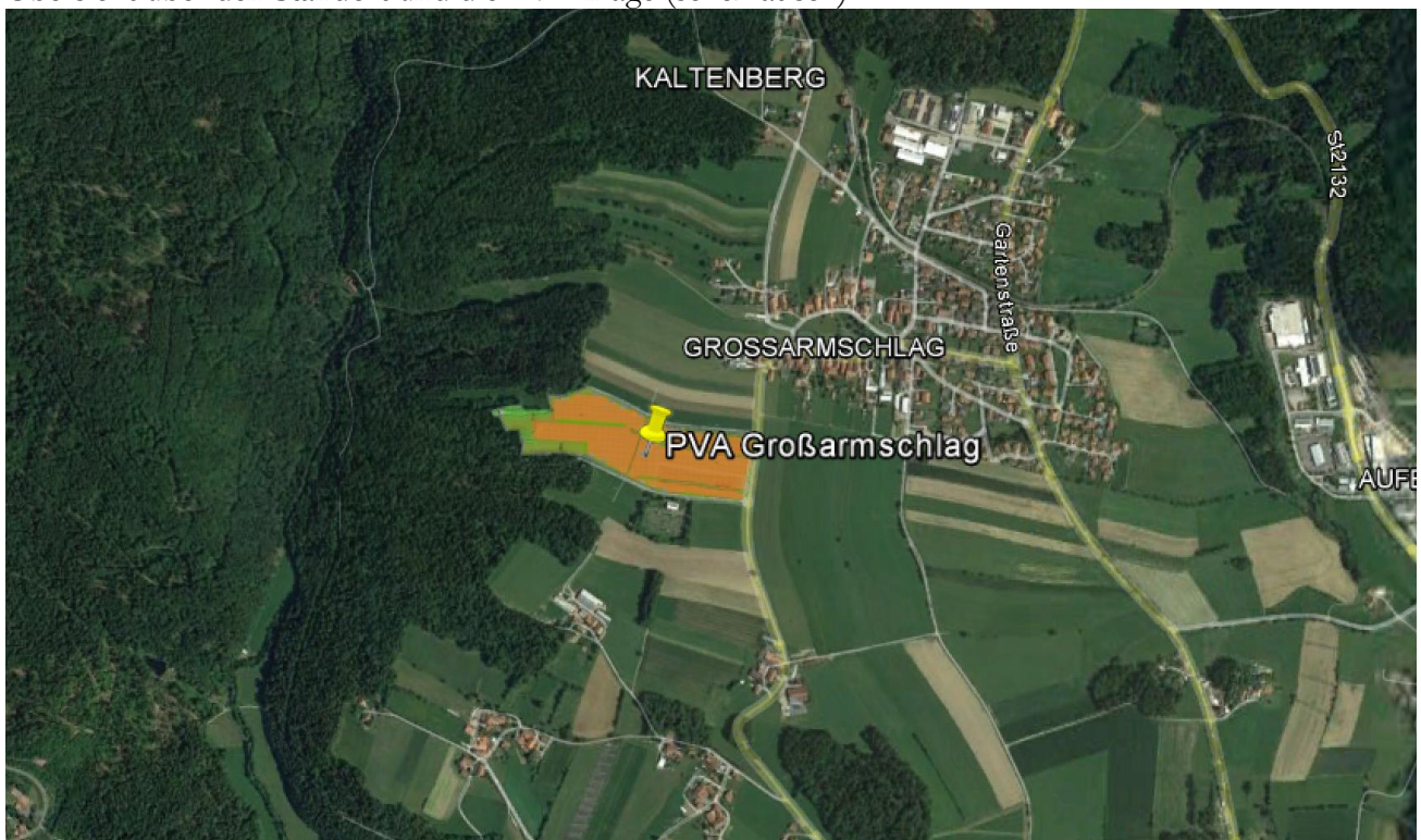
Bild 2.1.1: Luftbild der PV-Anlage (Quelle: Google Earth / SolPEG)
